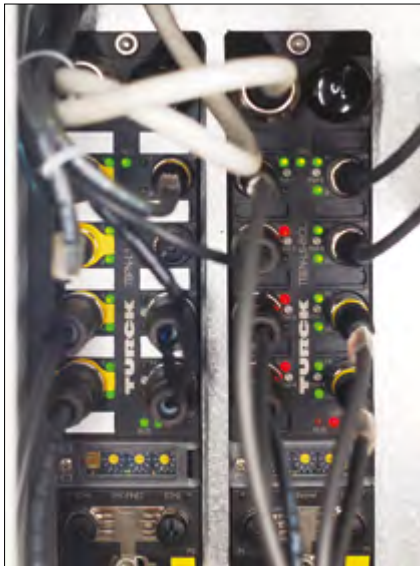
Rys. 2. Kompaktowy moduł I/O TBEN-L z ARGEE realizuje funkcje sterownika, natomiast hybrydowy moduł TBPN pełni kluczową rolę w systemie bezpieczeństwa maszyny
