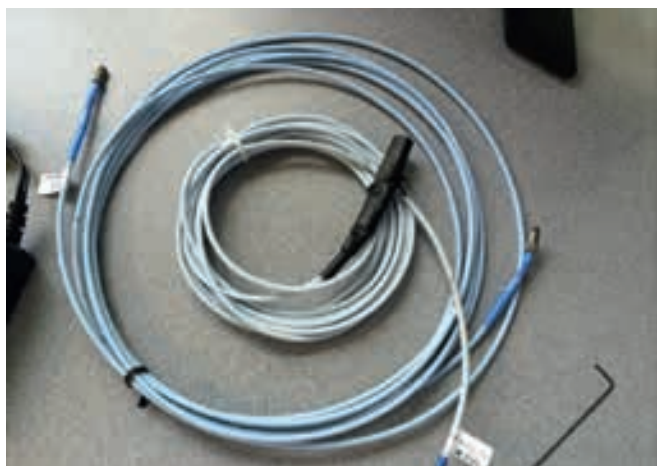
Nieprawidłowe okablowanie może wywoływać alarmy w nieodpowiednim momencie: zbyt wcześnie lub zbyt późno.
